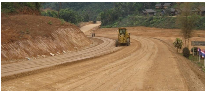
รูปที่ ๒-๑๒ รถเกลี่ยปรับแต่งระดับชั้นสุดท้ายหลังจากบดอัดแน่นได้ที่แล้ว
