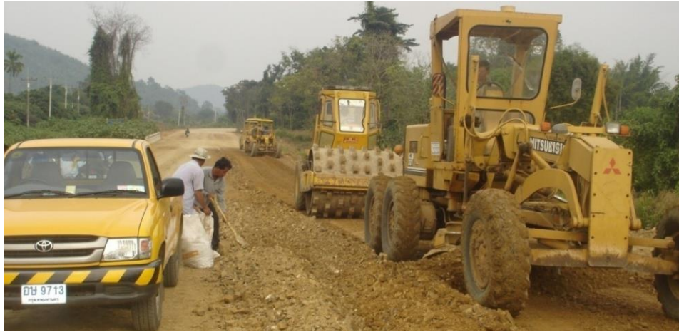
รูปที่ ๒-๘ รถเกลี่ยกำลังเกลี่ยกระจายวัสดุมวลรวมเพื่อก่อสร้างชั้นรองพื้นทาง
