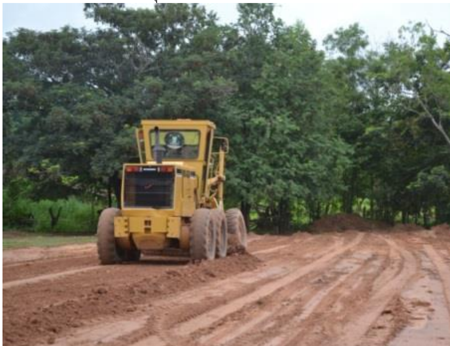
(๒) วัสดุที่คายออกจากไถมีดเลยพื้นล้อหลังทางขวา รูปที่ ๔-๓๘ การปรับระดับพื้นผิววัสดุด้านซ้ายมือ
