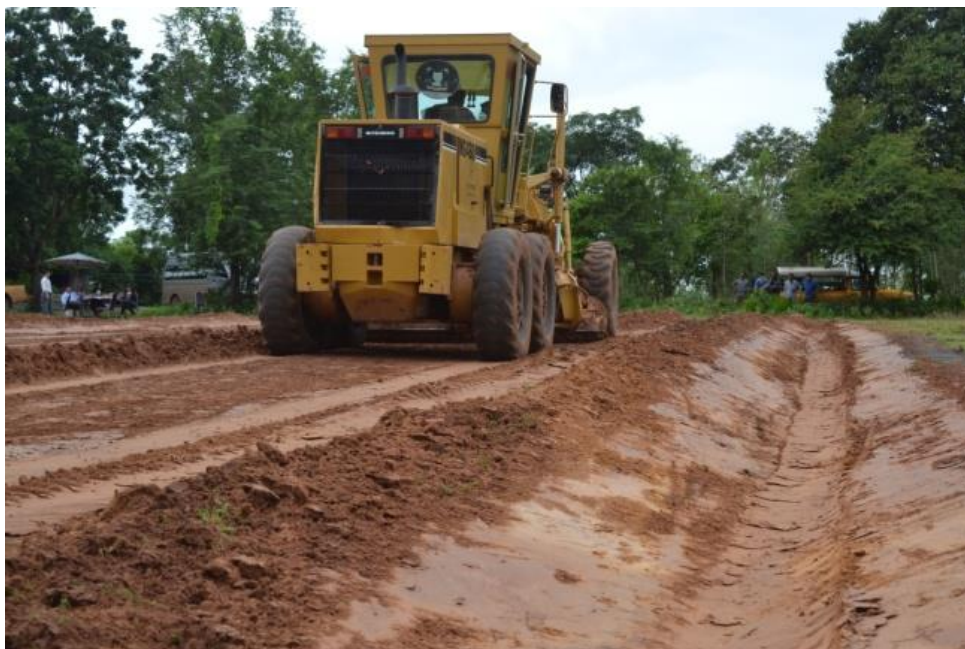
(๑) ทำความสะอาดกำจัดวัสดุที่ล้นขึ้นมาบนขอบถนน
