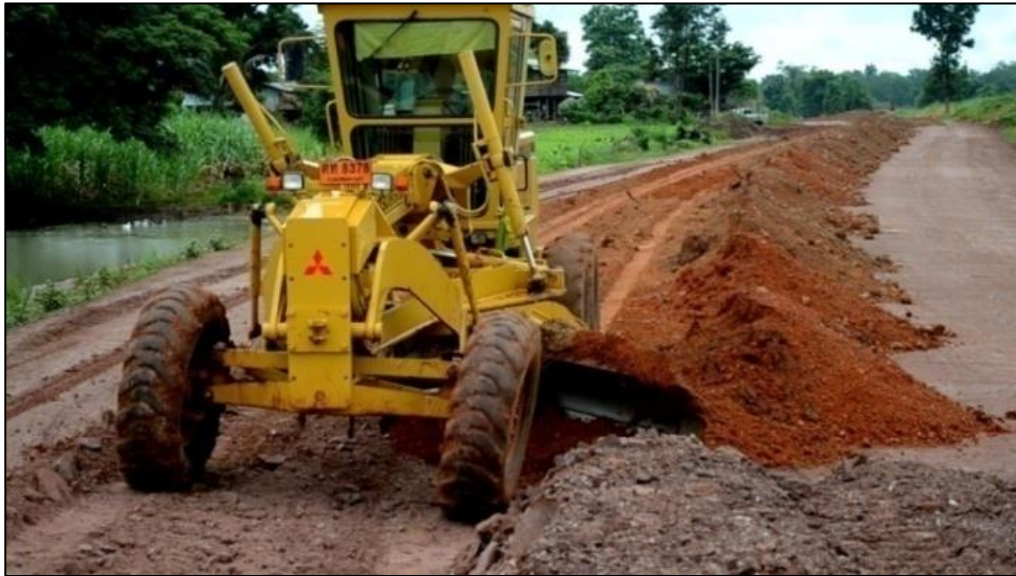
รูปที่ ๔-๒๔ การวางใบมีดในการลัดกองวัสดุ
