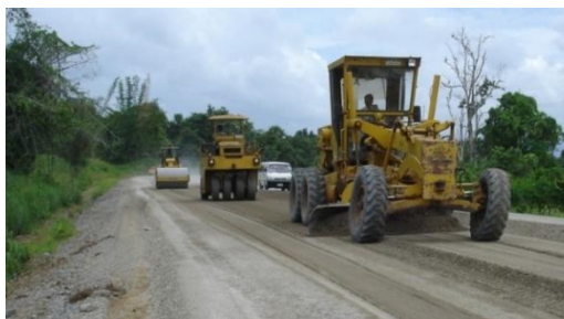
รูปที่ ๒-๙ รถเกลี่ยกำลังเกลี่ยกระจายปูหินคลุกที่คลุกเคล้าได้ที่ดีแล้วโดยรถบดบดทับตามมา
