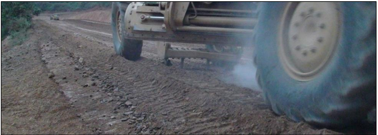
รูปที่ ๒-๔ รถเกลี่ยขุดรื้อโครงสร้างทางเดิมเพื่อก่อสร้างใหม่
