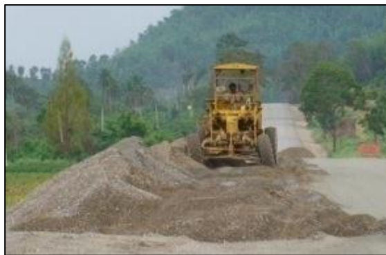
รูปที่ ๒-๖ รถเกลี่ยล้มกองวัสดุหินคลุกเพื่อเตรียมคลุกเคล้าให้เข้าเป็นเนื้อเดียวกันสม่ำเสมอ
