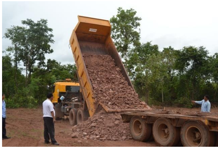
(๑) เทกองวัสดุท้ายรถเทรลเลอร์
