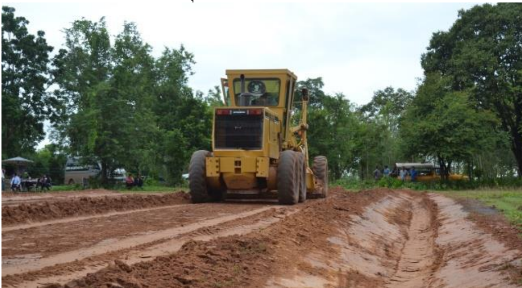
(๒) วัสดุที่คายออกจากไถมัดเลยพื้นล้อหลังทางซ้าย รูปที่ ๔-๓๖ การปรับระดับพื้นผิววัสดุด้านขวามือ
