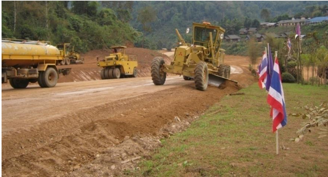
รูปที่ ๒-๑๓ รถเกลี่ยกำลังปรับแต่งลาดคันทางเมื่อก่อสร้างแล้วเสร็จแต่ละชั้น
