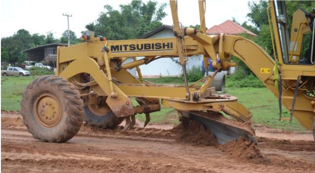
(๑) ไถมัดทำมุมประมาณ ๖๐ องศา กับเฟรมด้านขวา
