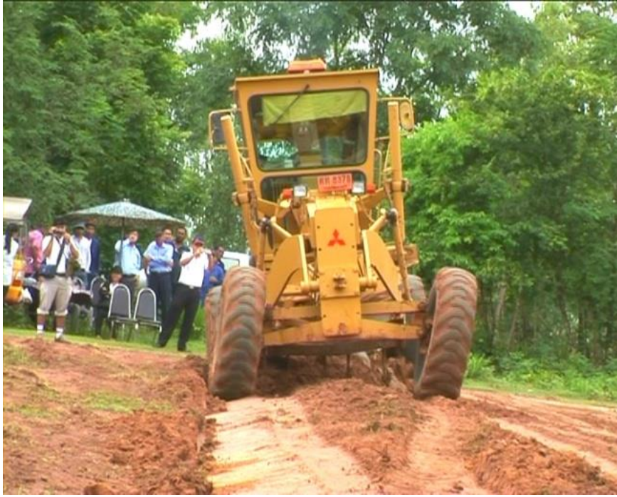
รูปที่ ๔-๔๓ การเอียงล้อรถเกลียวไปทางซ้ายมือ
