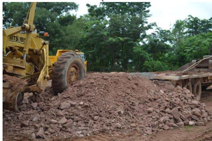
(๒) เกลี่ยและบดอัดทางขึ้นให้แน่น
