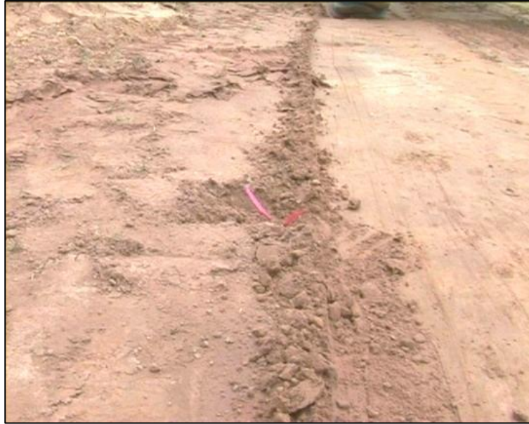
(๑) การใช้ใบมีดปาดเกลี่ยระดับหมุดและจำระดับของหมุดแต่อันว่าจะต้องตัด (cut) และต้องเพิ่ม (fill) วัสดุตรงจุดไหนบาง
