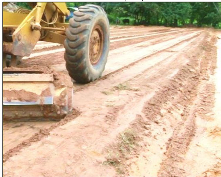
(๒) การใช้ใบมีดปาดเกลี่ยให้ระดับจริงให้เสมอระดับที่ปาดดูหมุดครั้งแรก รูปที่ ๔-๒๙ การตัดเกลี่ยให้ได้ระดับหัวหลัก(เป็ก) ที่กำหนด
