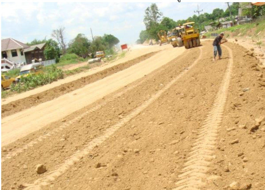
(๒) รถบดล้อตามด้วยรถบดสันสะเทือน
