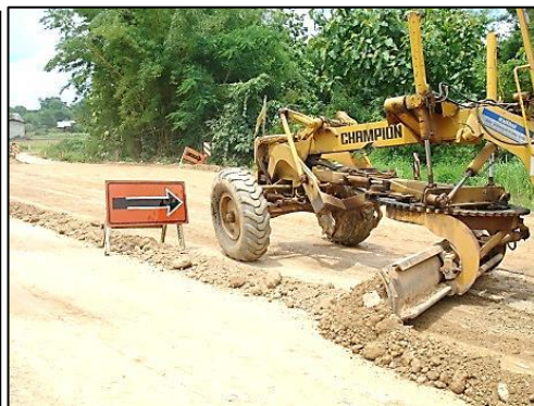
รูปที่ ๔-๓๐ การปรับระดับพื้นผิววัสดุผ่านรอบสิ่งกีดขวางขั้นตอนที่ ๑
