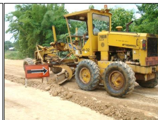
รูปที่ ๔-๓๑ การปรับระดับพื้นผิววัสดุผ่านรอบสิ่งกีดขวางขั้นตอนที่ ๒
