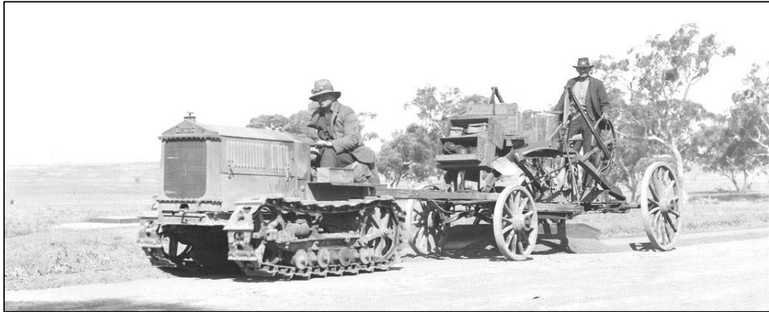
รูปที่ ๑-๖ รถเกลี่ยแบบใช้รถแทรกเตอร์ตีนตะขาลากจูง
