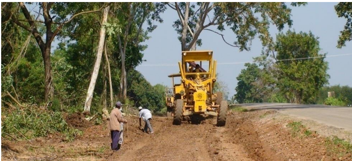
รูปที่ ๒-๒ รถเกลี่ยปรับพื้นดินในงานขึ้นดินเดิม
