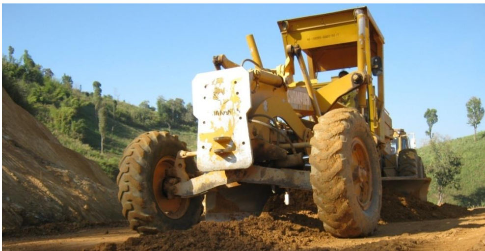
รูปที่ ๒-๑๑ รถเกลี่ยกำลังขุดหรือขึ้นทางที่ก่อสร้างแล้วแต่เกิดมีจุดอ่อนตัวเพื่อแก้ไข
