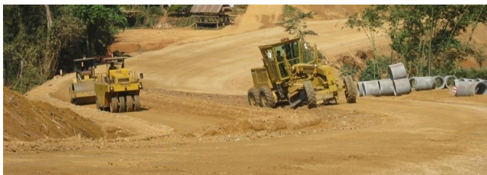
รูปที่ ๒-๑๐ รถเกลี่ยกำลังขุดรื้อชั้นทางที่ก่อสร้างแล้วแต่เกิดมีจุดอ่อนตัวเพื่อแก้ไข
