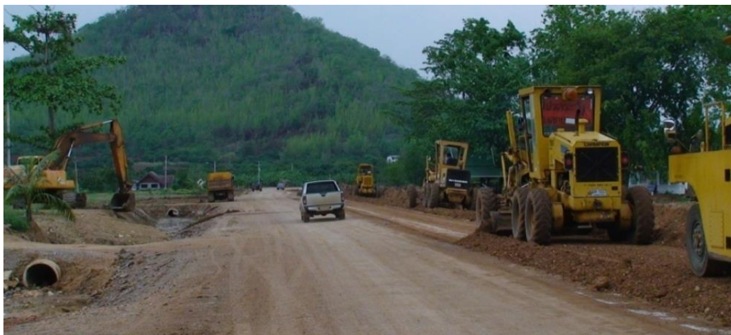
รูปที่ ๒-๗ รถเกลี่ยกำลังเกลี่ยกระจายวัสดุมวลรวมเพื่อก่อสร้างชั้นวัสดุตัดเลือก
