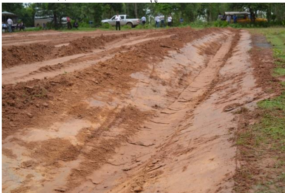
(๒) ร่องน้ำรูปตัววีที่เสร็จสมบูรณ์ รูปที่ ๔-๔๖ การตัดร่องรูปตัววีขั้นตอนสุดท้าย
