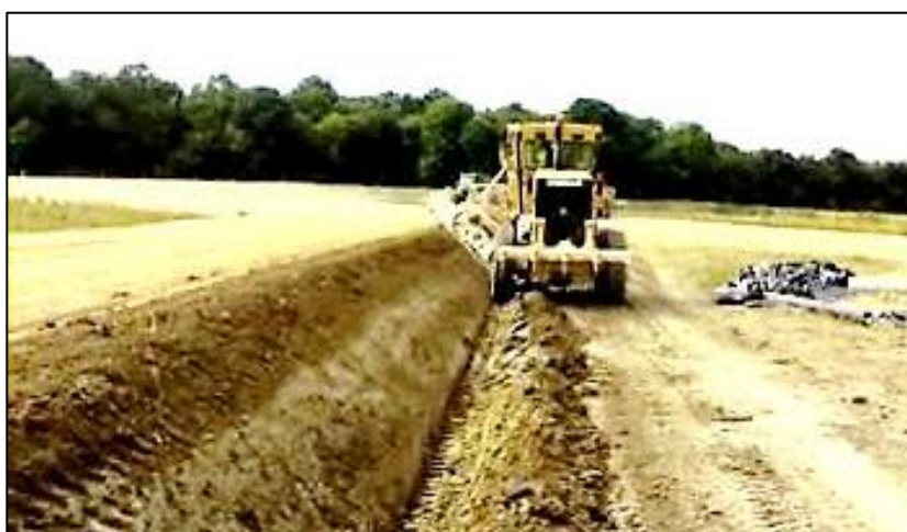
รูปที่ ๔-๕๓ การตัดสโลปไหล่ทางทางด้านซ้ายมือ
