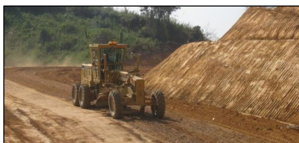
รูปที่ ๒-๓ รถเกลี่ยในงานขึ้นรูปคันทาง
