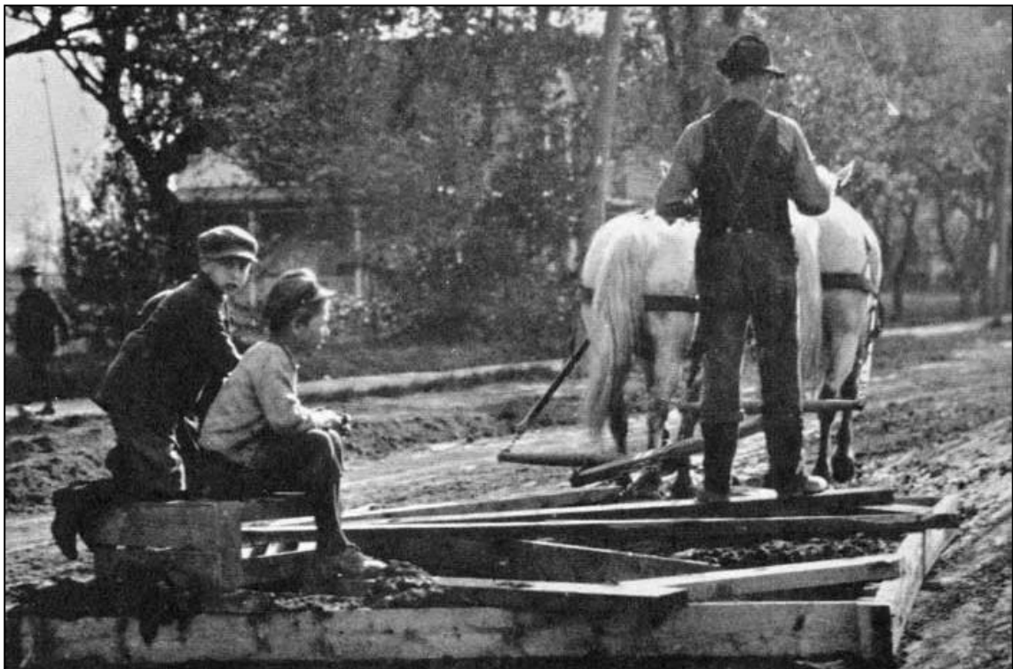
รูปที่ ๑-๑ การเกลี่ยดินแบบใช้แรงงานสัตว์ชักลากกระบะ
