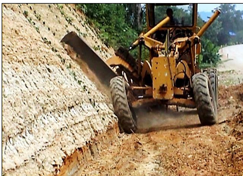
รูปที่ ๔-๕๒ การเอียงล้อช่วยขณะตัดสโลป
