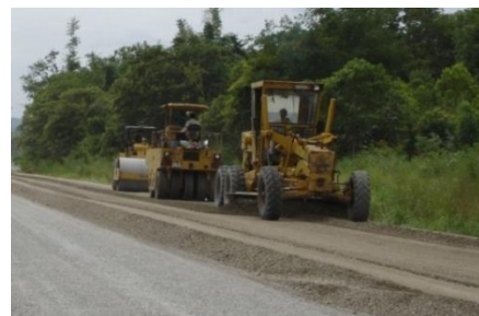
รูปที่ ๒-๙ รถเกลี่ยกำลังเกลี่ยกระจายปูหินคลุกที่คลุกเคล้าได้ที่ดีแล้วโดยรถบดบดทับตามมา
