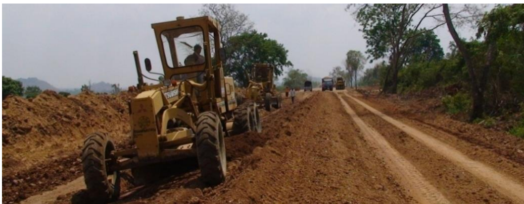
รูปที่ ๒-๕ รถเกลี่ยคลุกเคล้าดินให้เข้าเป็นเนื้อเดียวกันเพื่อเตรียมชั้นรูปคันทาง
