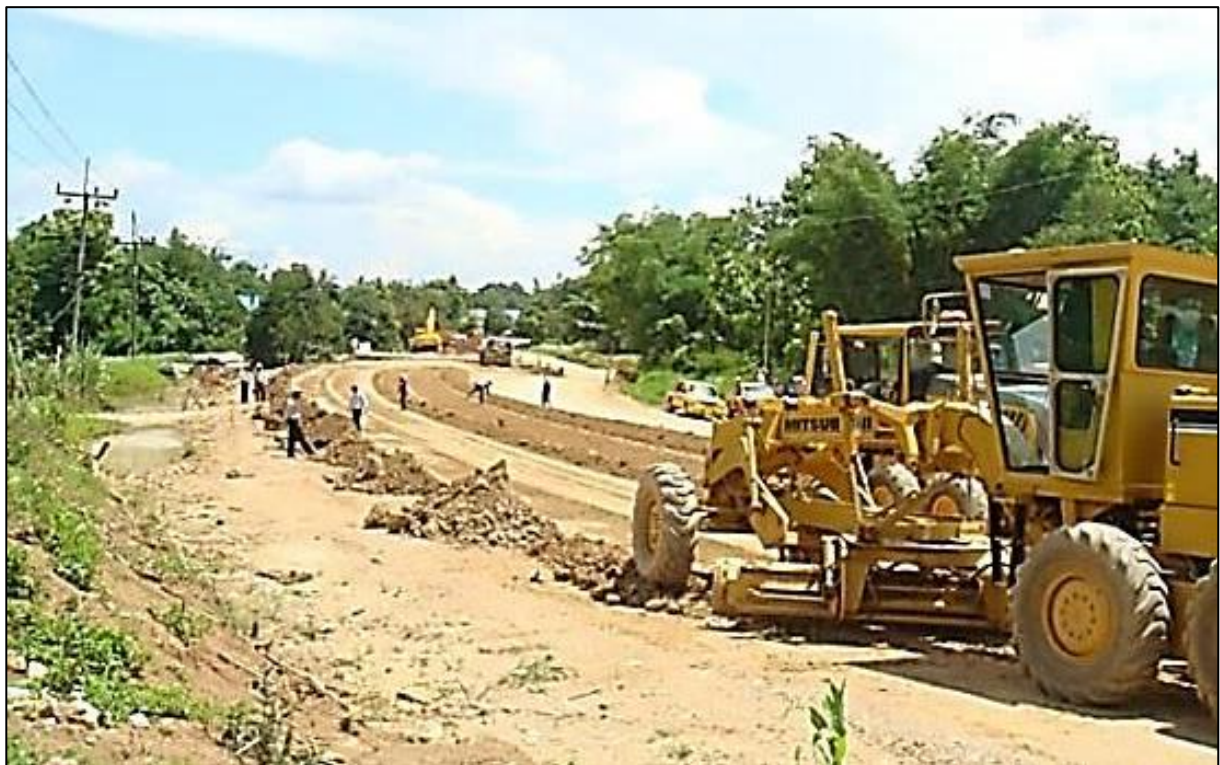
รูปที่ ๔-๒๗ การใช้รถเกลี่ย ๒ คัน โดยคันที่หนึ่งลั่นกองแล้วให้คันที่สองคลุกเคล้าวัสดุ
